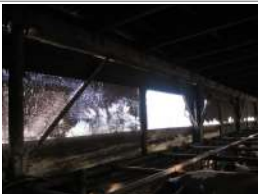
Obrázek 34: Potrhaná a zaprášená protiprůvanová síť postrádá v této stáji smysl.
