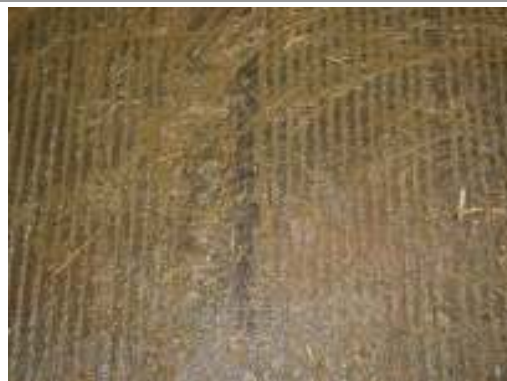
Obrázek 18: Profilace a rýhy v podlaze by měly zaručovat eliminaci klouzání končetin a bezpečnost pohybu.
