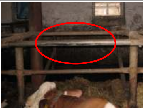
Obrázek 12: Lesklá plocha vymezení zábrany svědčí o jeho špatném nastavení.
