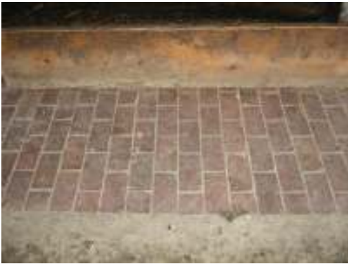
Obrázek 27: Tmavá dlažba není nejvhodnějším řešením podlahoviny žlabového prostoru. Zejména při oslunění v letních měsících, dochází k znehodnocování krmiva.
