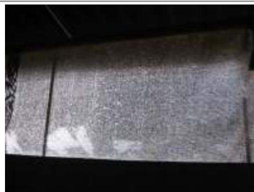
Obrázek 59: Protiprůvanové sítě, mající zajistit větrání čekárny, jsou funkční pouze tehdy, jsou-li čisté.
