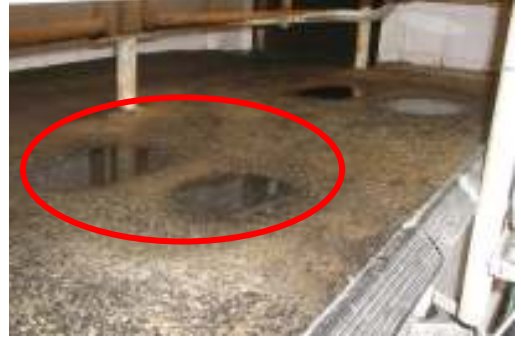
Obrázek 61: Výtlučky dojícího stání vypovídají o stáří a únavě dojírny.
