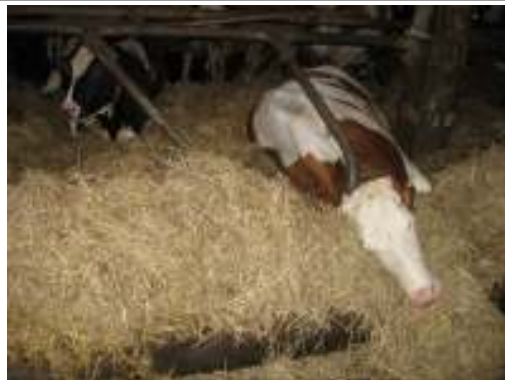
Obrázek 11: Umožnit dojnícím zaléhat do boxu obráceně, je nejen hrubou konstrukční, ale i chovatelskou chybou!
