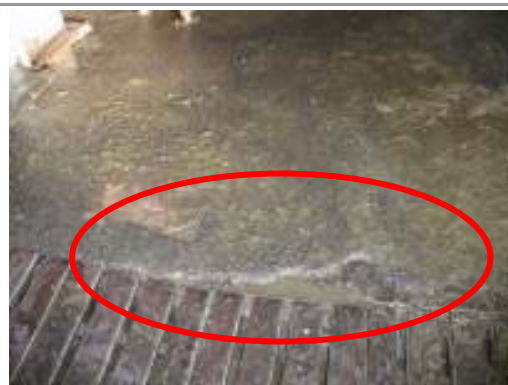
Obrázek 55: Výtluky v podlaze čekárny mohou způsobovat také poranění nášlapné plochy paznehtu.
