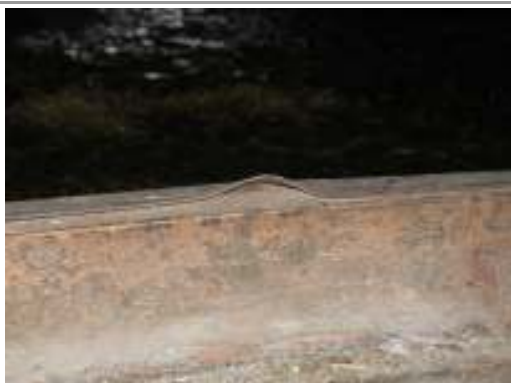
Obrázek 21: Deformace kontaktní plochy požlabnice může způsobit dojnícím poranění.
