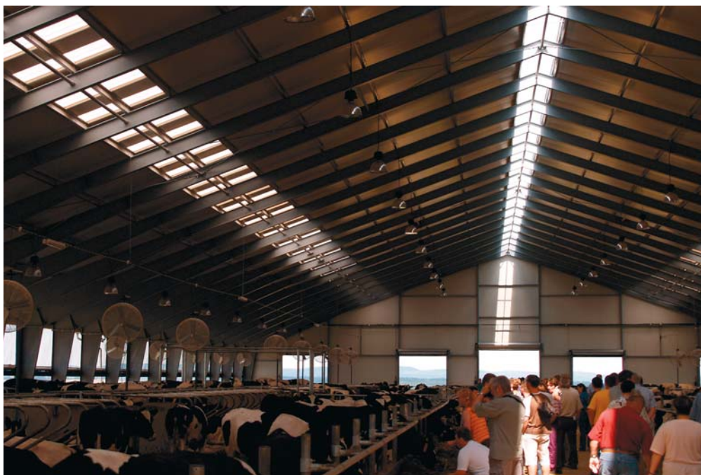
foto 13: Zateplené střešní podhledy bohužel umožňují pouze horizontální prosvětlení se všemi nevýhodami. Na druhé straně je zde dokonalé řešení nezakryté hřebenové štěrbin.
