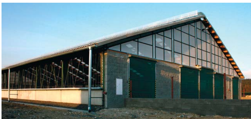
foto 3: Přirozená ventilace stáje - boční zástěny jsou shrnuté, vrata z protipřuvanové sítě jsou zatažená. Parapet by mohl být i nižší, na úrovni 40 až 60 dm, pokud stáj nestojí v podhůří s vyššími sněhovými srážkami.
