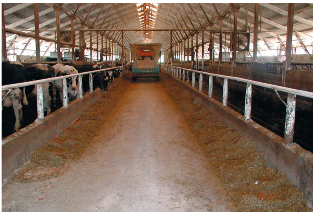
foto 21: Úzká krmná chodba < 360 cm umožňuje nežádoucí přejíždění krmiva koly traktoru a krmného vozu.
