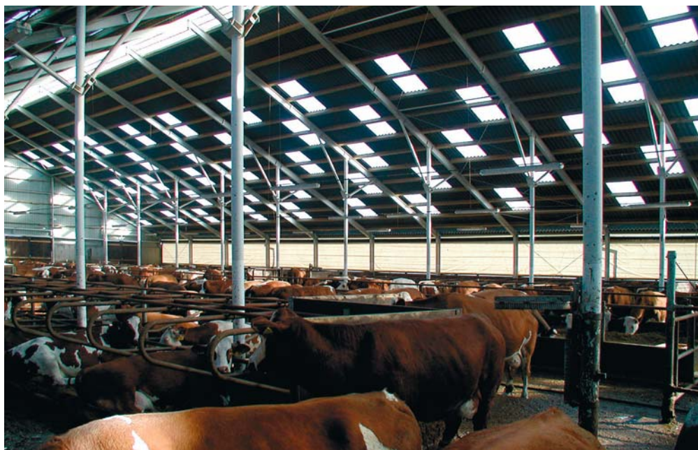
foto 10: Přesvětlení stáje může znamenat riziko skleníkového efektu, který může snadněji vyvolat tepelný stres u dojnic. U této stáje je navíc nezohledněna expozice vůči severní a jižní straně.
