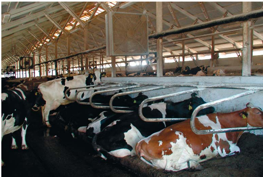
foto 14: Dělicí stěny mezi boxy či oddělující boxy a krmíšče jsou nevhodné. Brání přirozené výměně vzduchu a kontaktu mezi zvířaty. V letním období jsou i škodlivé pro pohodu zvířat.
