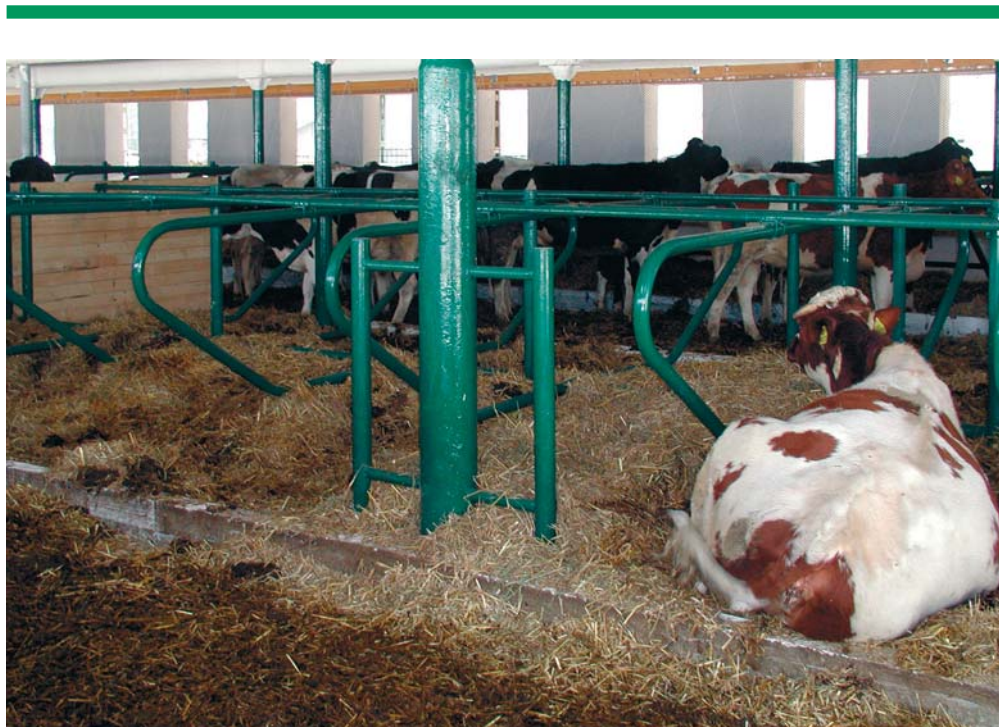
foto 37: Pokud při rekonstrukci stáje nosný sloup vychází na konec boxového lože, je lepší toto lože tzv. „vyslepit“ i za cenu snížení kapacity stáje.
