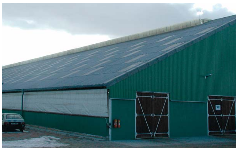
foto 1: Chybou je, když se zamezí příčnému provětrání stáje uzavřením bočních stěn.
