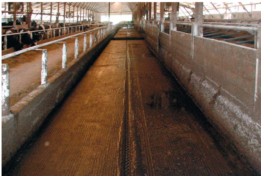
foto 19: Úzké krmíště s pevnou stěnou oddělující boxová lože jsou již překonanou variantou zasluhující radikální řešení.
