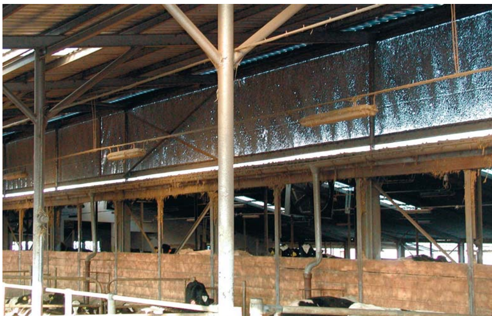
foto 6: V rekonstruované stáji by měly protiprůvanové sítě sloužit jako přirozená ventilace. Po několika měsících však takto postrádají svou funkci. Nutné je jejich čištění alespoň 2x do roka!
