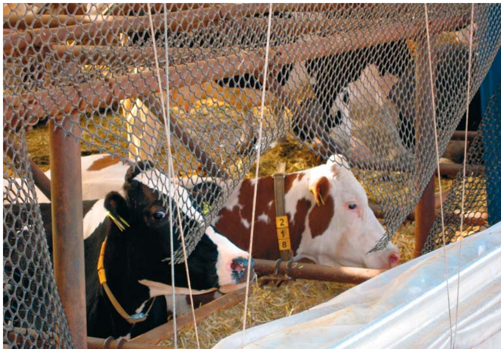
foto 7: Roztrhané opěrné pletivo v obvodové stěně stáje není dobrou vizitkou chovatele.
