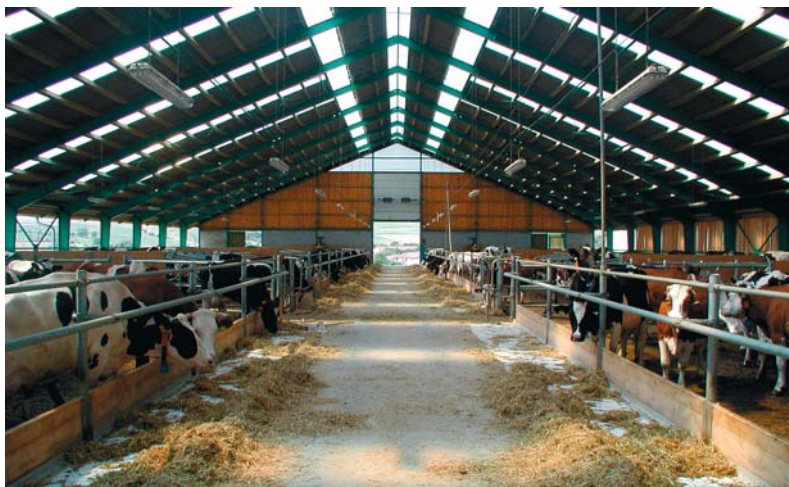
foto 9: Prosvětlení po spádu střechy má jednu nevýhodu, a to je horší kvalita a distribuce světla v profilu stáje (krmný stůl event. boxové lože).
